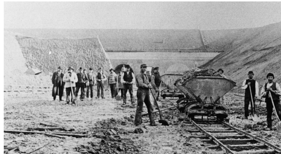
Opførelsen af Garderhøjfort i 1886. Her ses de forholdsvis primitive arbejdsforhold. Gravearbejdet blev udført med skovl og spade, og jorden blev transporteret væk på tipvogne.
